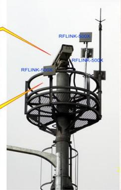
기존에는 주로 고속도로의 광케이블을 이용하였으나, 설치 비용 절감 및 공사기간 단축을 위해 당사 무선 장비 (RFLINK-500 시리즈) 를 이용하여 구축하였습니다.
